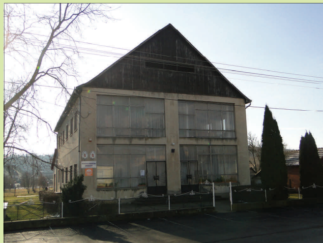
Az épület felújítás előtt
